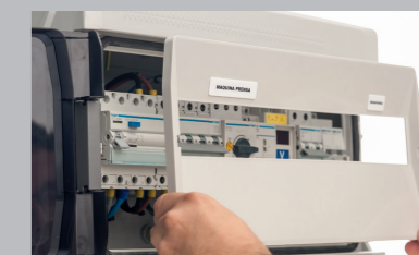
Odnímatelný krycí rámeček modulových přístrojů – urychluje instalaci
