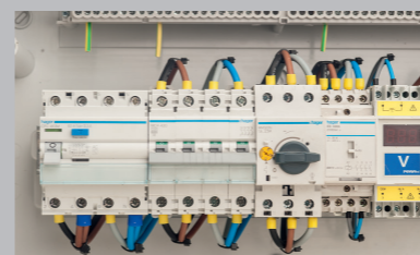
Dostatek prostoru pro kabeláž Wide space for the cabling
